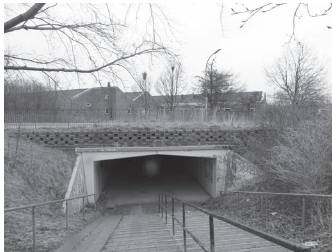
Tunnel under Bybjergvej
