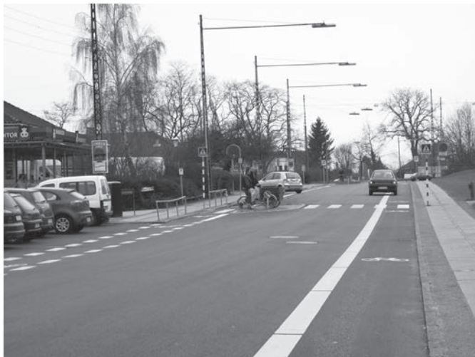
Fodgængerovergang på Bybuen ved Center Nord
