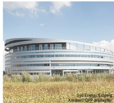
Eksempel på integrerede installationer
